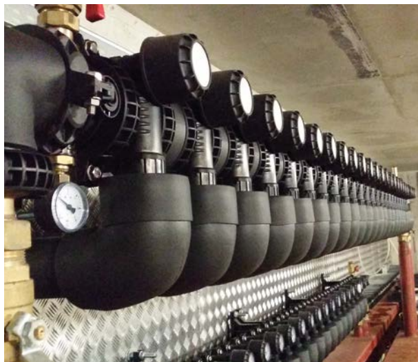
Фотография показывает 27-контурный коллектор ProCalida GT3 в системе грунтового теплообменника теплового насоса. Система находится в торговом центре Huta в местечке Węgierska Góra (Южная Польша).
