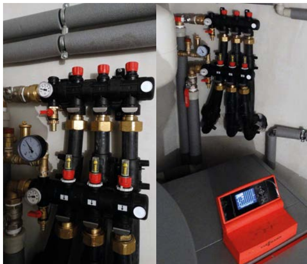
Фотографии показывают 3-контурный коллектор ProCalida IN в системе теплового насоса. Система находится в коттедже в местечке Turza Śląska (Южная Польша).
